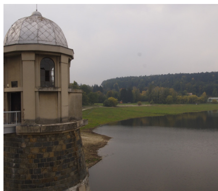
Obr. 5: Bude voda opět zelená? Po rozsáhlém odbahnění Plumlovské přehradní nádrže (vpravo) nemáme jistotu, zda bude voda dostatečně kvalitní. Fosfor má tedy vstup zakázán: vlevo zásobníky síranu železitého v kontejnerech, dávkovaného hadicemi do všech přítoků. Přetvořit povodí nádrže tak, aby dodávalo čistší vodu, se zdá být nadále nadlidským úkolem, o který jsme se v tomto případě ani nepokusili. Foto David Pithart
