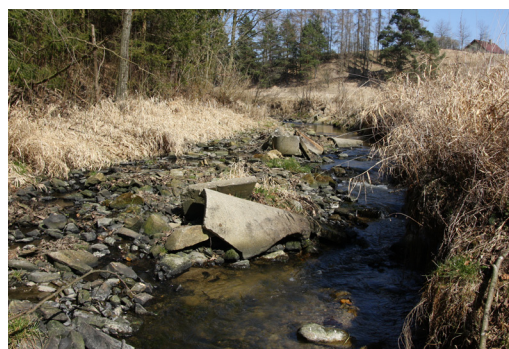
Obr. 2: Kanál se pomalu stává opět potokem. Olešnice (vlevo) a Chmelenský potok, Křemžská kotlina. Zbývá vodohospodářskou stavbu odepsat a vyradit z evidence. Přejde-li koryto de iure do stavu „přírodního“, správce toku již není povinen „napravovat“ jeho případné změny. I když může, uzná-li to za vhodné. Foto David Pithart
