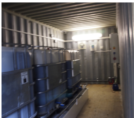
Obr. 5: Bude voda opět zelená? Po rozsáhlém odbahnění Plumlovské přehradní nádrže (vpravo) nemáme jistotu, zda bude voda dostatečně kvalitní. Fosfor má tedy vstup zakázán: vlevo zásobníky síranu železitého v kontejnerech, dávkovaného hadicemi do všech přítoků. Přetvořit povodí nádrže tak, aby dodávalo čistší vodu, se zdá být nadále nadlidským úkolem, o který jsme se v tomto případě ani nepokusili. Foto David Pithart
