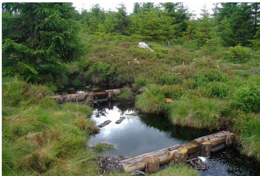
Jeden z hlavních sběrných kanálů po dvou letech od provedení opatření, 2011. Foto Pavel Kolibáč
