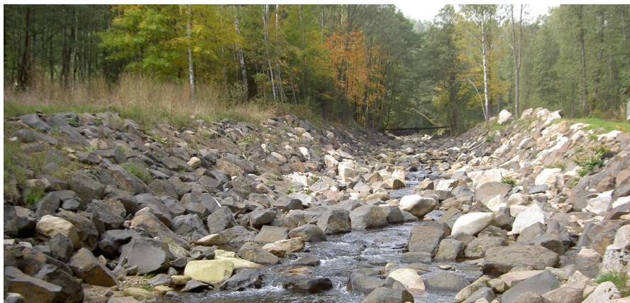
Na Rolavě nad Nejdkem byly dva stabilizační prahy nahrazeny balvanitými skluzy a úpravou toku. Foto Miloš Holub
