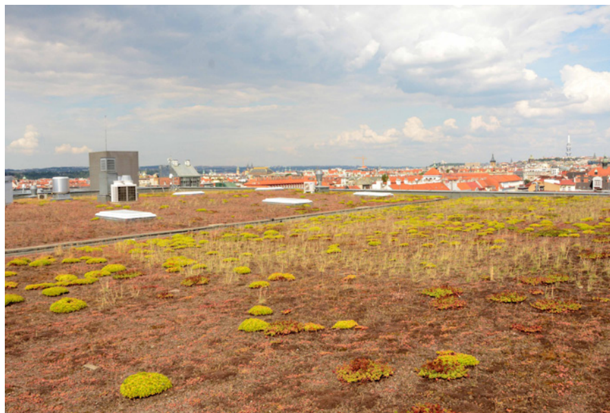
Obr. 3 Step na Obchodním centru Nový Smíchov je naprosto úžasným a konstrukčně relativně jednoduchým prvkem, který významně přispívá k podpoře biodiverzity na překvapivém místě. Foto Ondřej Sedláček.
