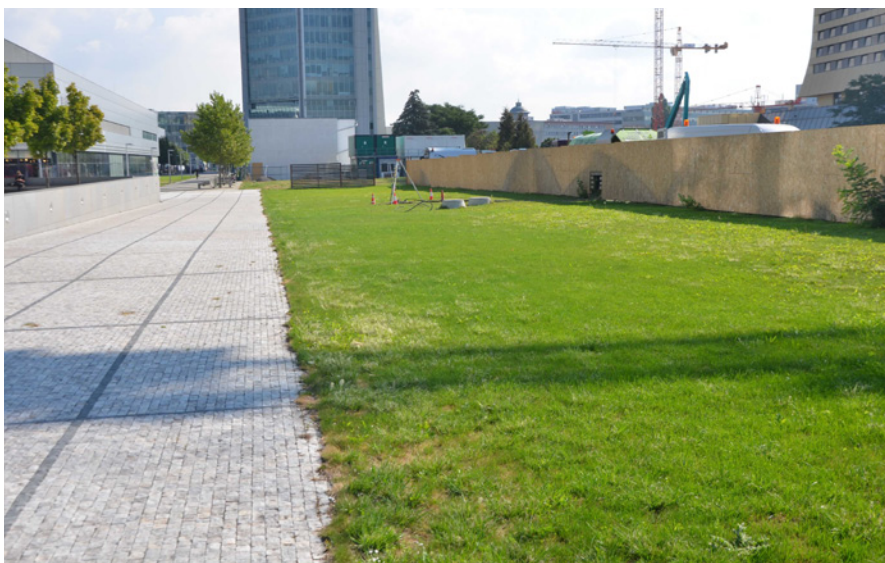
Obr. 4 Je škoda, když okolí budovy dominuje pouze beton, dlažba a intenzivně sekané trávniky (City Tower, Praha). Taková místa lze ale poměrně jednoduchými opatřeními významně oživit. Foto Ondřej Sedláček.
