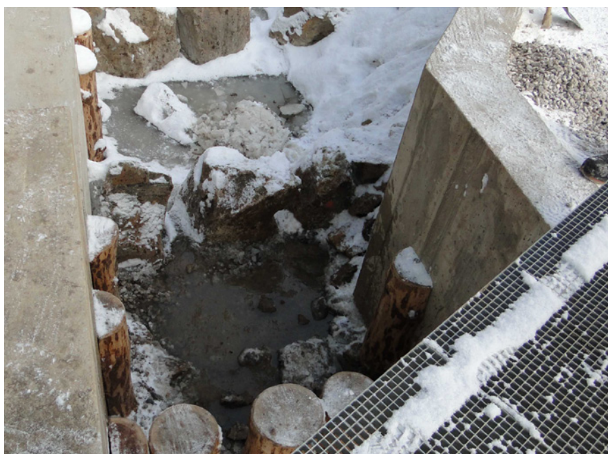
Detail vtokového objektu, rychlost proudění vody budou regulovat palisády z kulatiny. Foto Kateřina Kujanová
