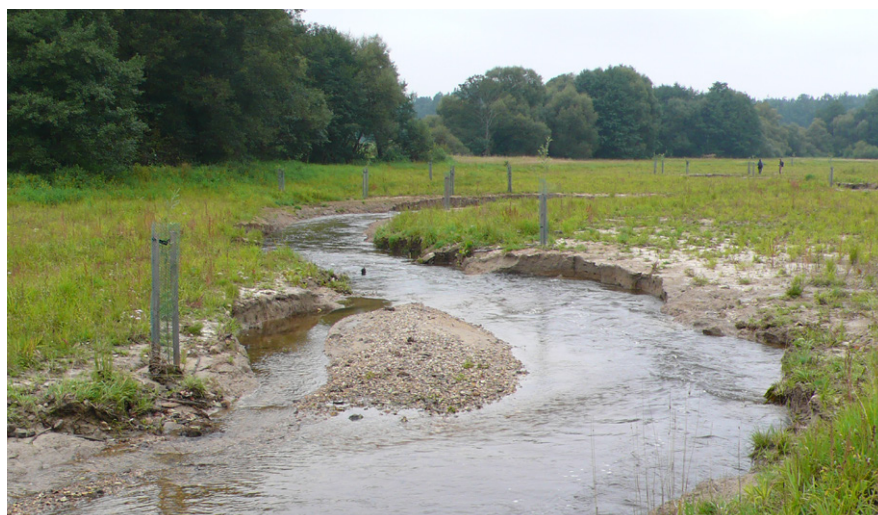
V roce 2014 provedlo Povodí Vltavy první etapu revitalizace Stropnice u Nových Hradů. Ještě v roce dokončení revitalizační stavby prošla Stropnicí menší povodeň, která dílo příhodně posunula dotvořením detailní členitosti koryta. „Kolaudační stav“ revitalizace byl poněkud syrový, avšak povodňový vývoj ukázal správnost rámcového návrhu koryta. Foto Tomáš Just
