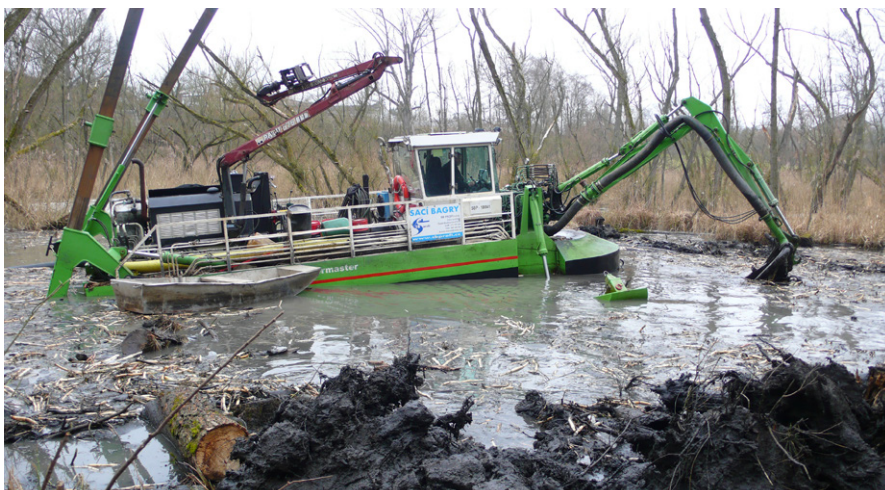
Odbahňování starých říčních ramen vždycky přírodu bolí, ale pokud by se nic nedělalo, vodní prvek by časem zanikl. Po všech stránkách jde o náročnou úlohu. 1915: Sací bagr odbahňuje vodní plochy ve starém rameni Labe u Týnce nad Labem. Akce města, dotovaná v rámci OPŽP. Foto Tomáš Just
