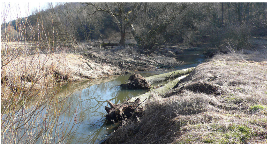
Jedna z rozmanitých možností posilování členitosti, stanovištní a úkrytové nabídky vodního toku, případně podpory samovolné renaturace – vkládání říčního dřeva. Foto Tomáš Just
