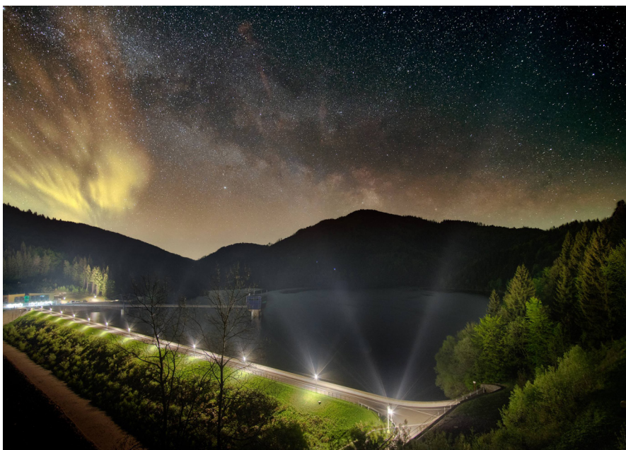
Svítlidla na hrázi přehrady Šance po jejich instalaci. Foto: Jan Kondziolka
