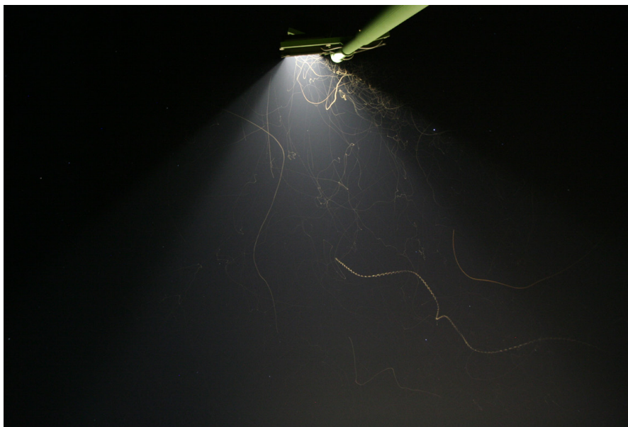
Rovný spodní kryt zajišťuje směřování světelného kuželu do spodního poloprostoru a výrazně omezuje světelné znečištění. Barva emitovaného světla však ani zde není vhodná. Foto: Jan Kondziolka
