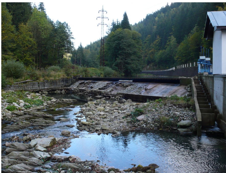
Jez na Labi s malou vodní elektrárnou v EVL Krkonoše. Foto Stanislav Březina
