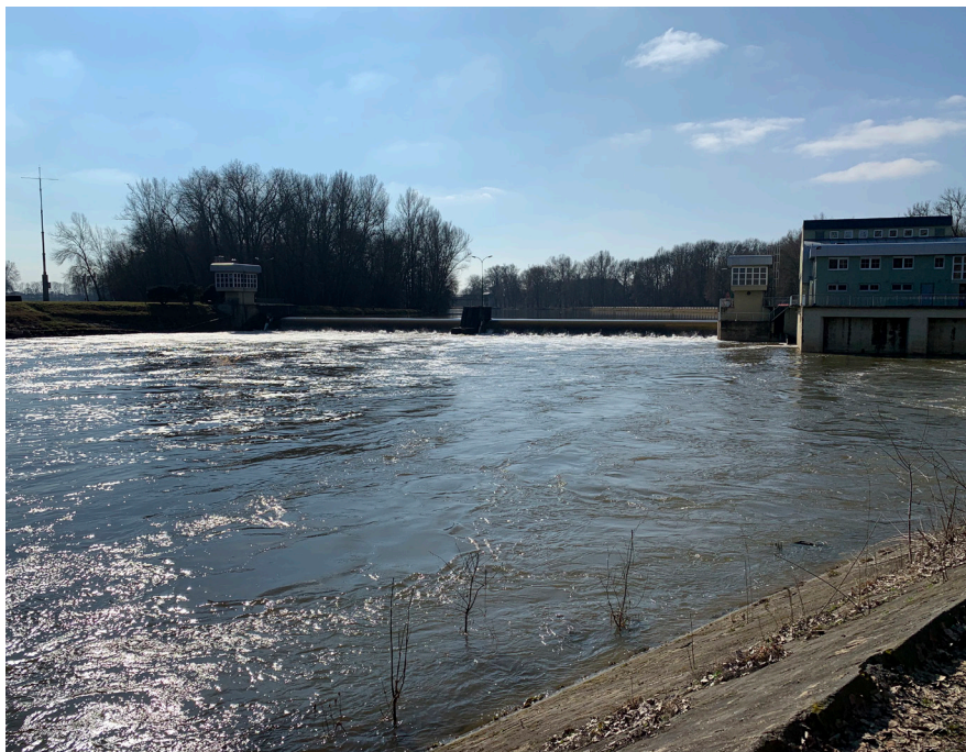
Bariéry příčné (Jez s vodní elektrárnou) i podélné (technické úpravy břehů) na Labi u Obříství. Foto Jan Dušek
